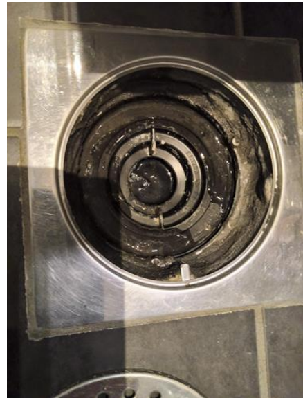
Slukets plassering i forhold til at vann utenfor dusjsonen kan nå det - [Sluket ved servant. Bad 1 etg ]
