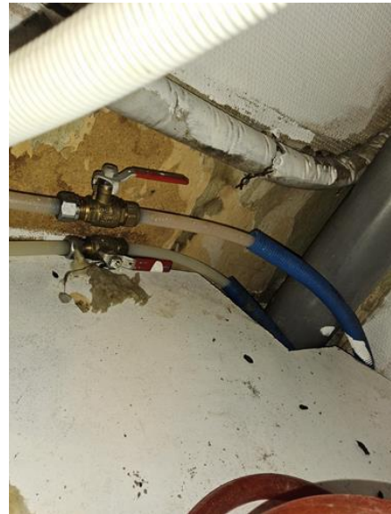
Vannrør - [Vannrør av typen rør-i-rør ]
