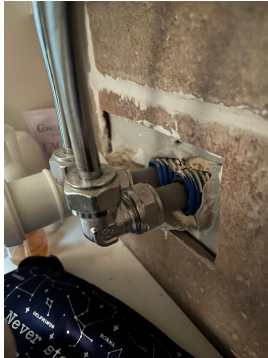
Utett rørgjennomføring i våtsone under vask.
