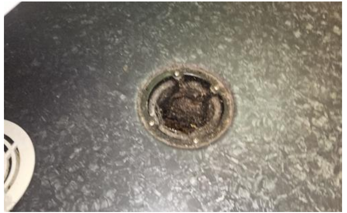
Avløpsrør - [Sluk på toalettrom.]
