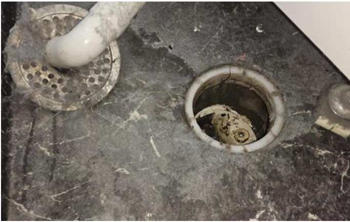
Membran, tettesjikt og overgang til sluk. - [Sluk i dusjsonen.]
