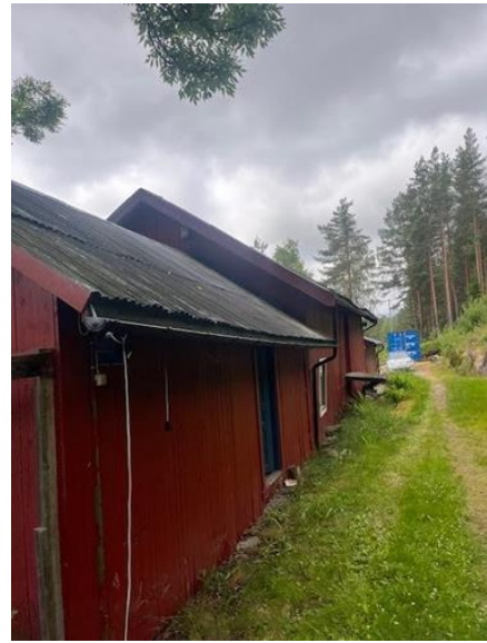
Utvendig - [Kjevheter låve.]
