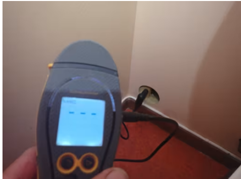
Fuktmåling i vegg fra tiliggende toalettrom
