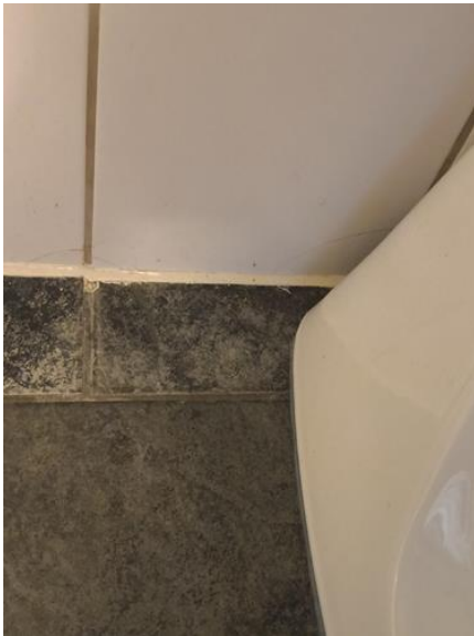
Overflater vegger - [Veggfliser ved toalett]
