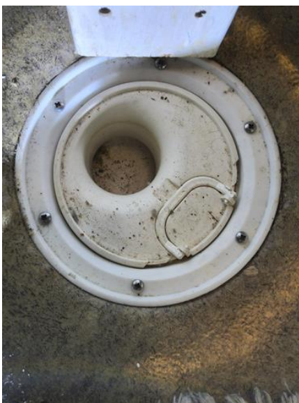
Slukets plassering i forhold til at vann utenfor dusjsonen kan nå det - [Sluket ved berder i bod.]
