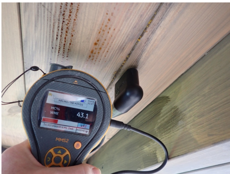
Fuktmåling i panel under veranda
