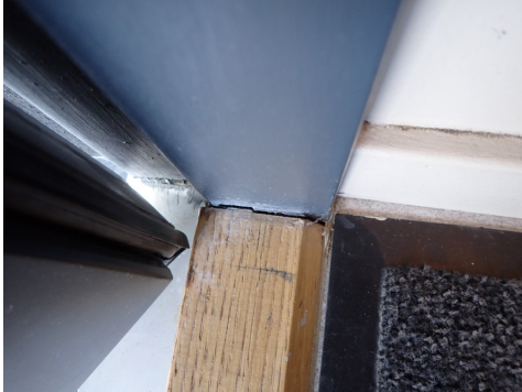
Sprekk mellom terskel og karm
