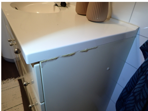
Fuktskader skrog
