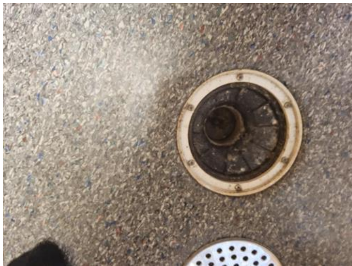
Membran, tettesjikt og overgang til sluk. - [Sluk vaskerom 1.etasje.]
