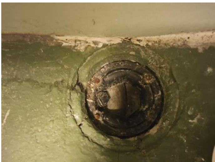
Membran, tettesjikt og overgang til sluk. - [Sluk vaskerom kjeller.]
