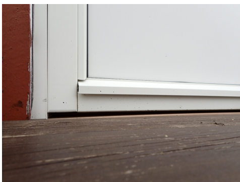
Dekke flukter med overkant terskel
