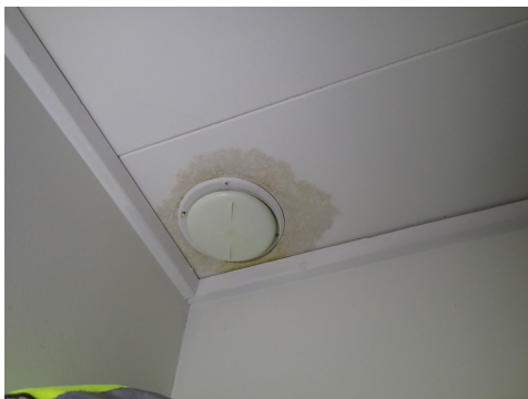
Fuktskjolder rundt venti
