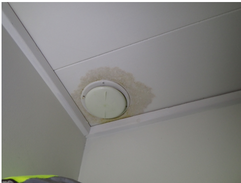
Fuktskjolder rundt venti
