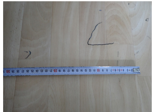
Skader i belegg, kjøkken
