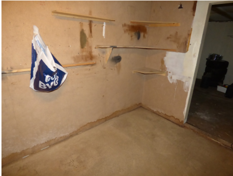
Eksempel på fuktmerker ved gulv
