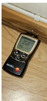
Fuktmåling fra tilstøtende soverom
