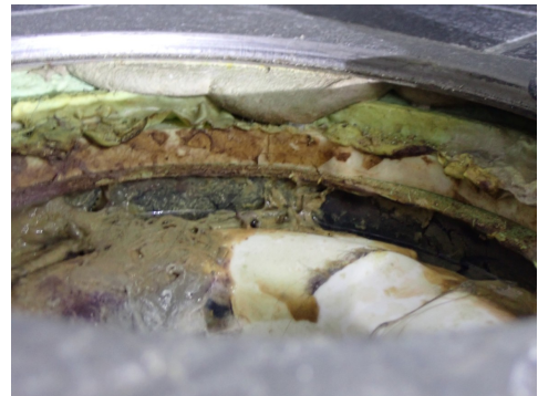
Sluk på bad/vaskerom
