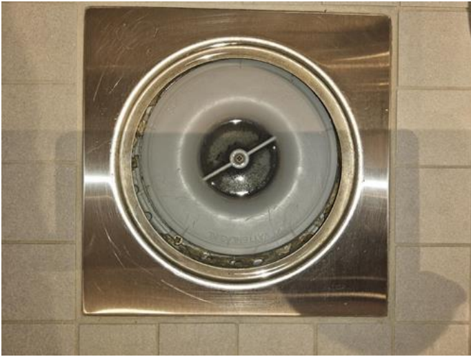
Våtrom - [Sluk bad.]
