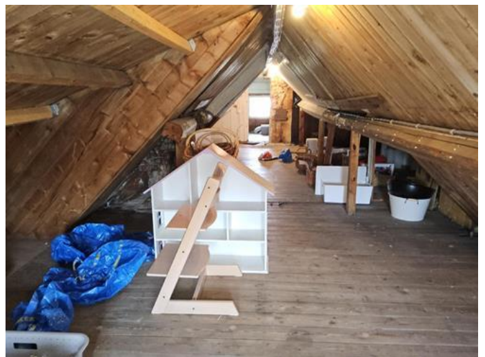
Loft - uinnredet / råloft - [Kaldtloft.]
