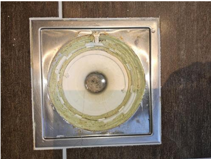
Våtrom - [Sluk bad dusjsone.]
