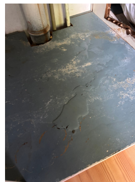
Viser pvc og kobber-rør ved luken til krypkjeller.
