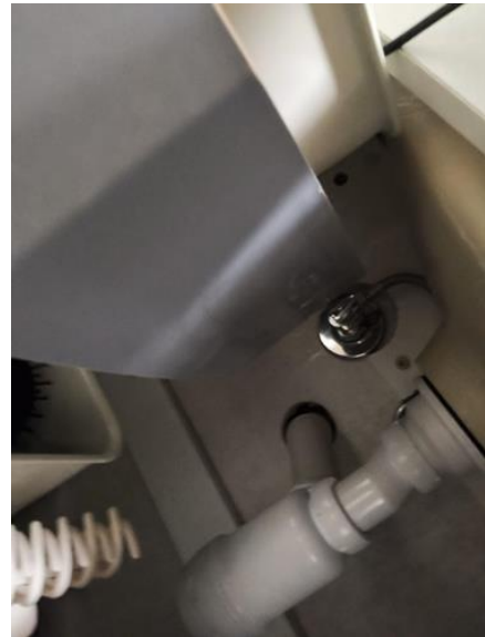
Membran, tettesjikt og overgang til sluk. - [Rørgjennomføring under vask på bad ]
