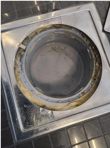
Slukets tilkomstmulighet for rengjøring - [Sluket i dusjsonen ]
