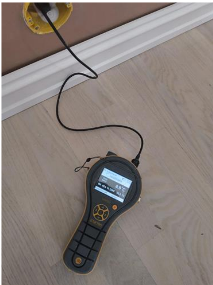
Fukt i tiliggende konstruksjoner - [Fuktmåling bad ]
