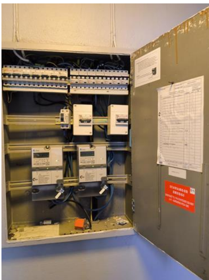
Elektrisk anlegg - [Sikringskap ]
