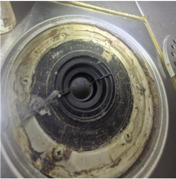
Våtrom - [SLuk bad]
