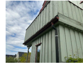
Takrenne i stål ved balkong 2.etasje
