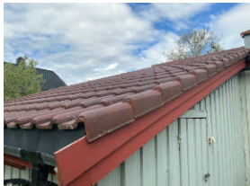
Svai i tak over bod/garasje.
