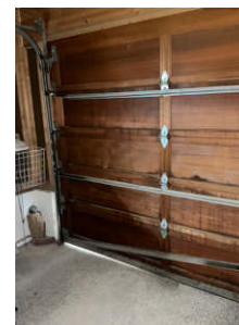
Utett mellom port og gulv.
