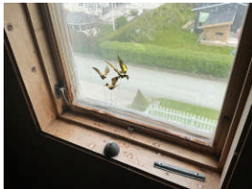
Vindu med koblet glass på loft.
