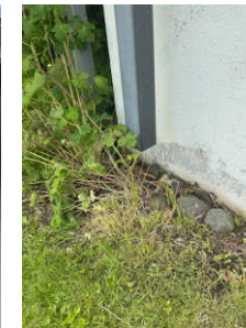
Taknedløp avsluttet over bakkenivå.
