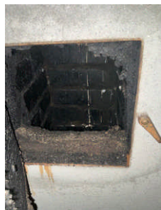
Inspeksjonsluke i pipe på loft.
