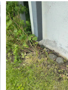
Taknedløp avsluttet over bakkenivå.
