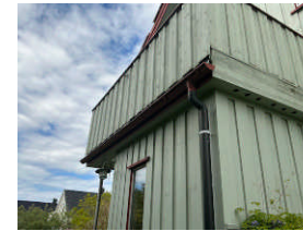
Takrenne i stål ved balkong 2.etasje
