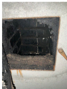
Inspeksjonsluke i pipe på loft.
