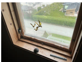
Vindu med koblet glass på loft.
