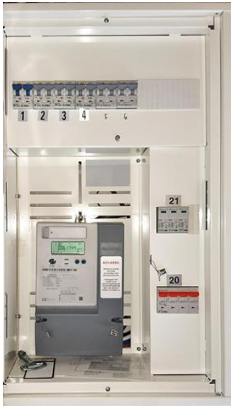
Forenklet vurdering av det elektriske anlegget - [Sikringsskap]
