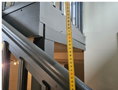
Rekkverk målt til 90cm
