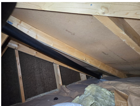
Rør på mørkeloftet over toalettrommet.
