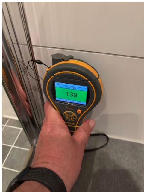
Fuktmåling fra tiliggende rom mot våtsone til bad/vaskerom, viser ingen fukt.
