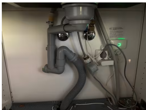
Avløpsrør i underskap vask på kjøkkenet.
