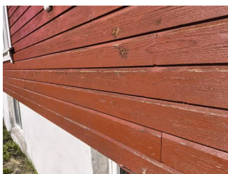
Overflatebehandling - Slitt overflatebehandling
