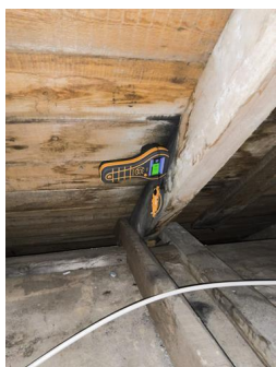
Synlige overflater (taktro, vegger, gulv, o.l) - Fuktmåling
