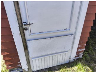
Ytterdører og omramming - Kjellerdør
