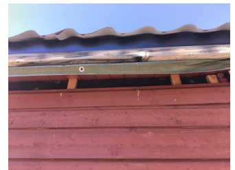
Yttertak og takkonstruksjon - Undertak av pressening
