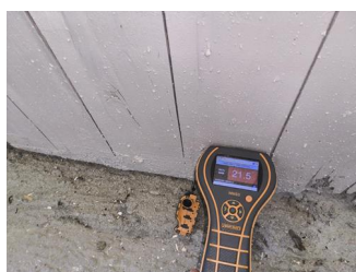
Kontroll i lukkede konstruksjoner - Fuktmåling
