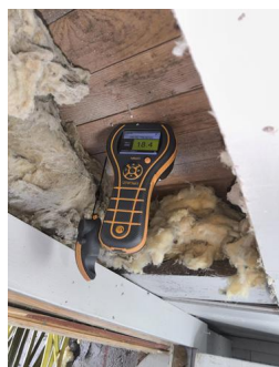
Kontroll i lukkede konstruksjoner - Fuktmåling i himling
