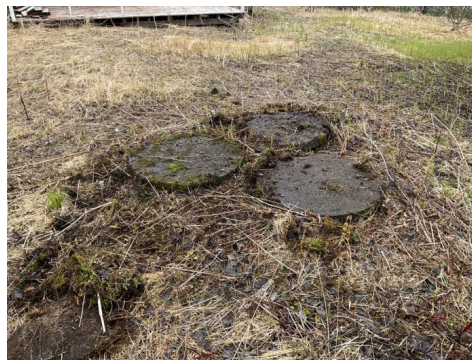
Lokk til 3-kammers septiktank.
