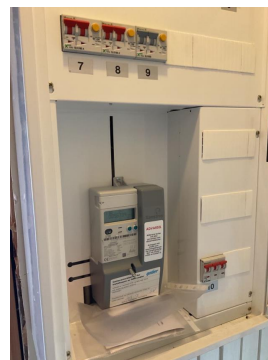
Nytt sikringsskap med automatsikringer i 2004. Ny måler fra 2017.
