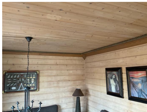
Hogget stokkpanel på vegger i kjøkken og stue.
