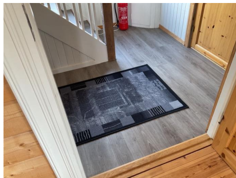
Laminat på gulvet i gangen.
