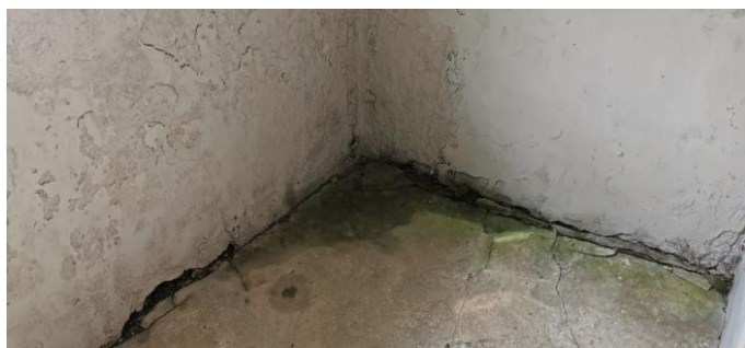
Fukttrentrengning i hjørne.
