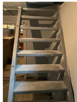
Kjellertrappa. Åpninger mellom trinn 14 cm.
