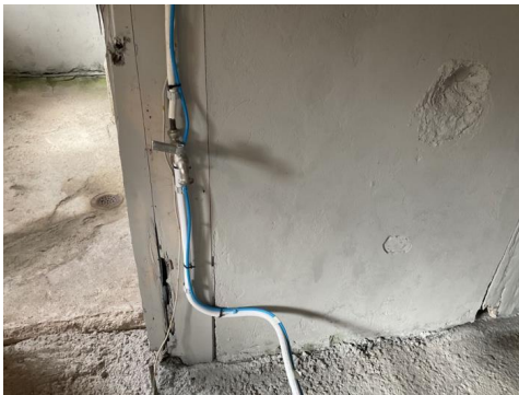
Kran for tilkopling av vaskemaskin.
