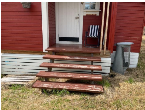
Trapp ved inngangen.
