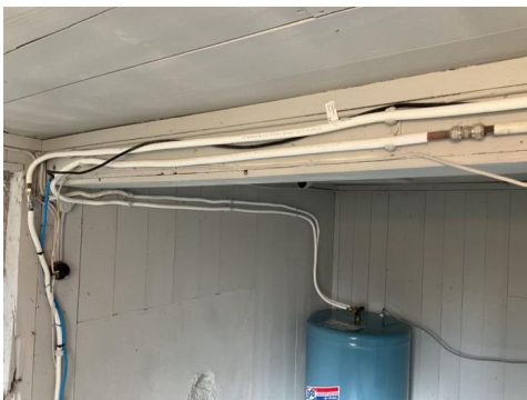
Kran for tilkopling av vaskemaskin.
