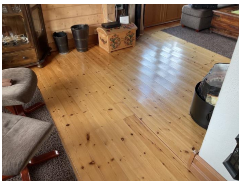
Lakkert furugolv i stua og på kjøkkenet.
