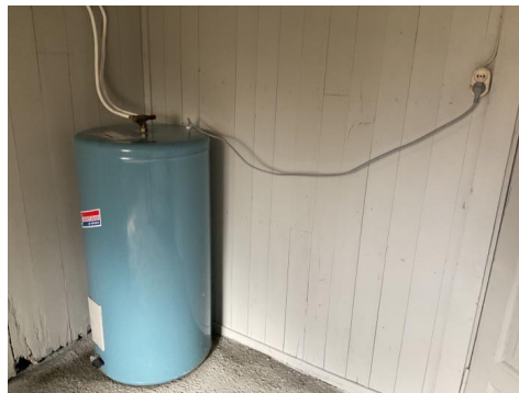
VVB 200 liters. Strømtilkopling via stikkontakt.
