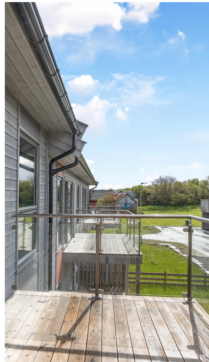
Utgang til balkong fra stue.
