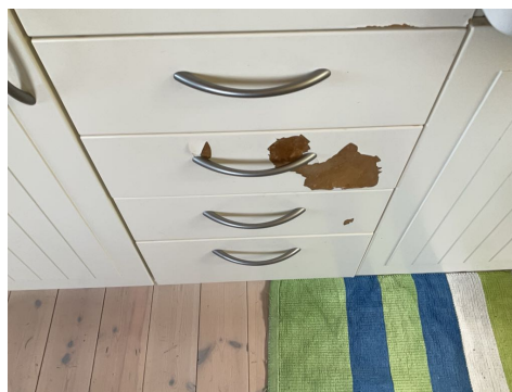
Skade på kjøkkenfronter,
