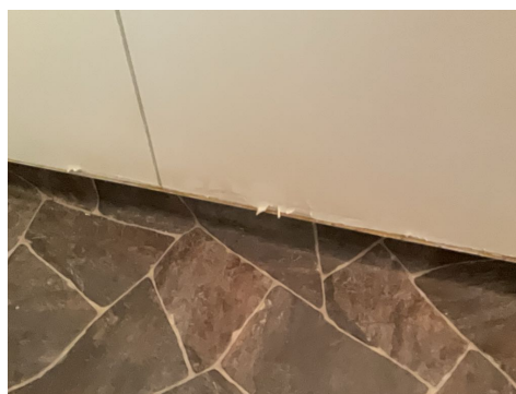
Eier har tettet med ekstra Silicon i nedre kant av våtromsplater.
