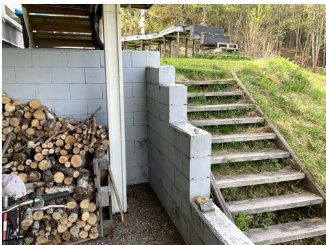
Støttemur ved trapp.
