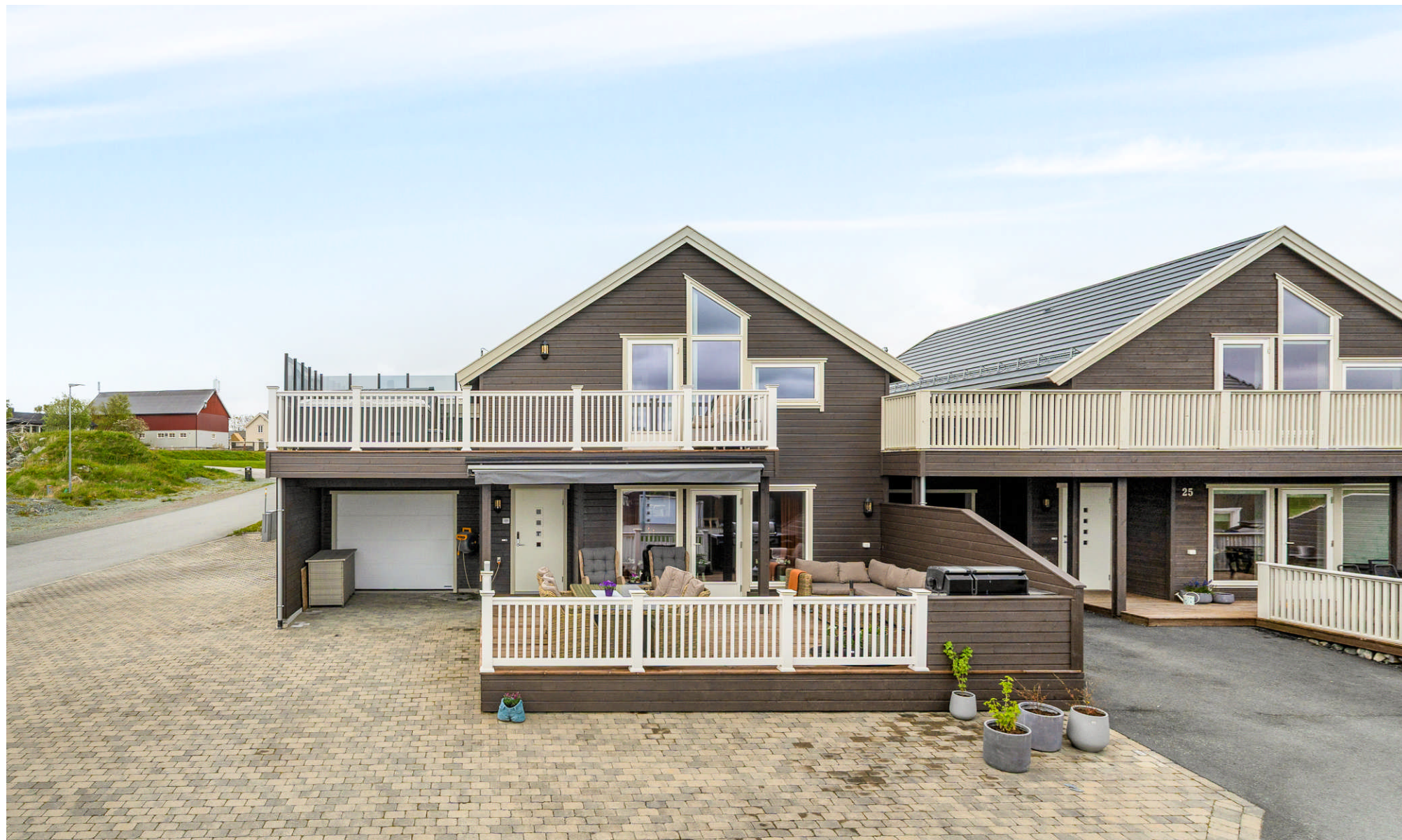
Herfra ser man størrelsen på balkongen i 2.etasje.
