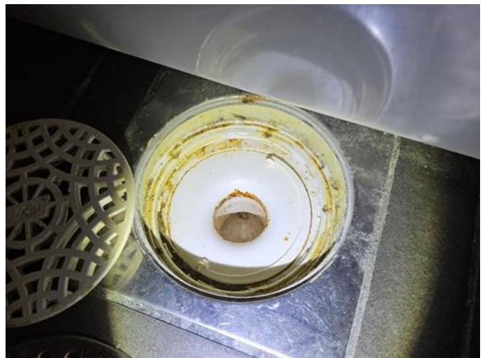
Våtrom - [Sluk på vaskerom. ]
