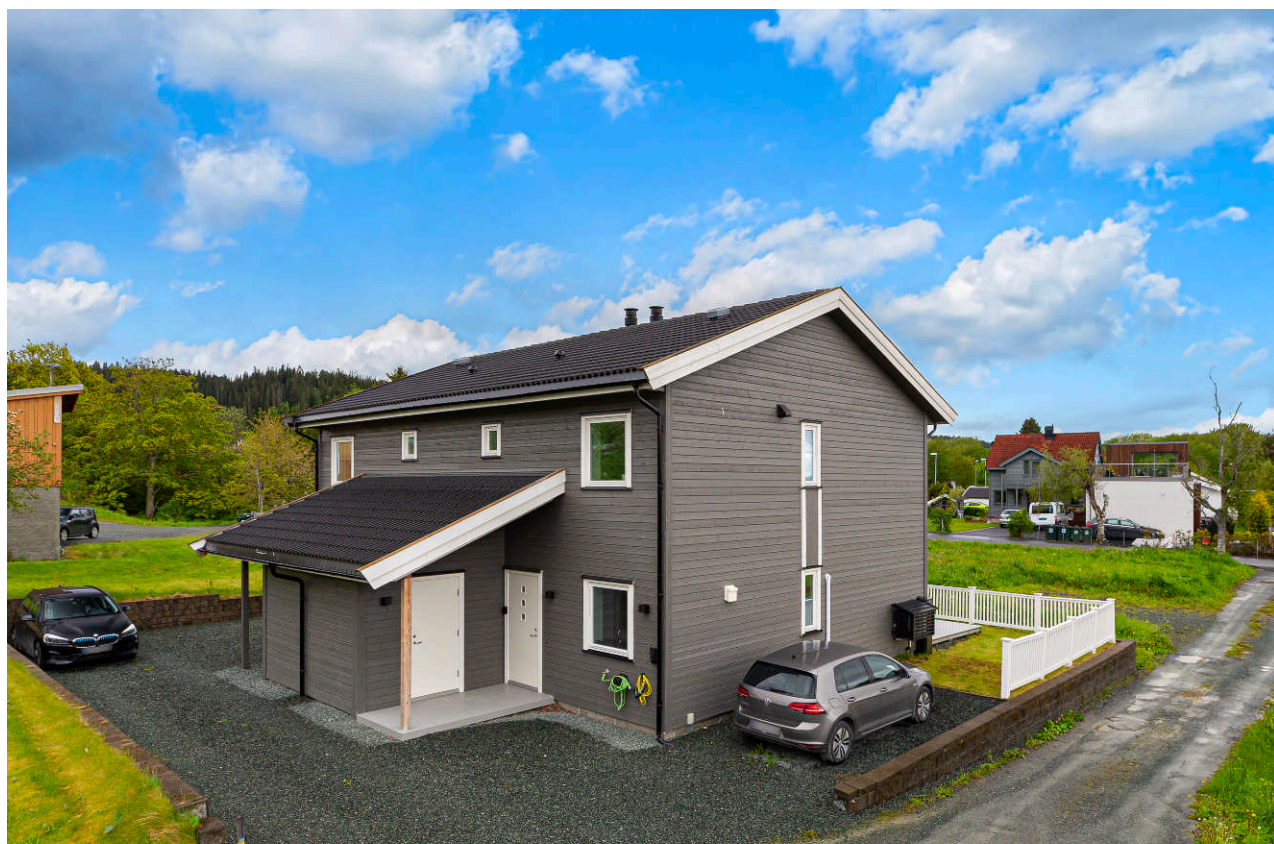
Pent opparbeidet med støttemur og flere biloppstillingsplasser ved huset.
