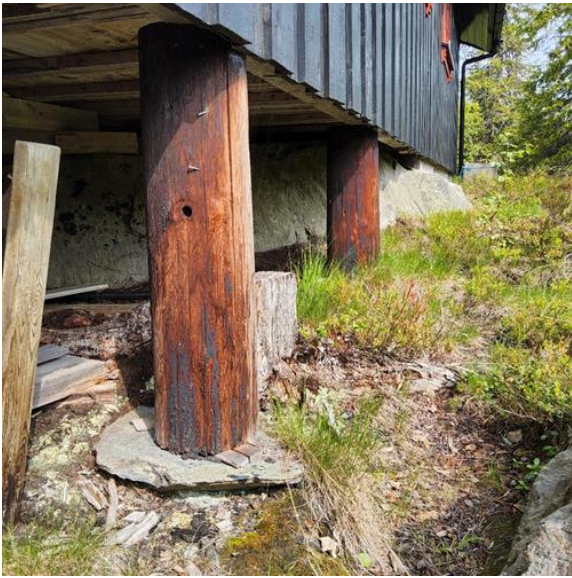
Utvendig - [Eksempel på provisoriske understøttelser under gammel del]
