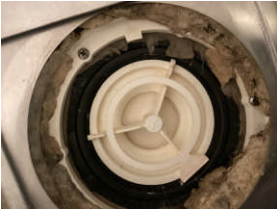
Bilde av sluk.
