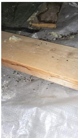
Innvendig inspeksjon - [Spor etter gnagere]
