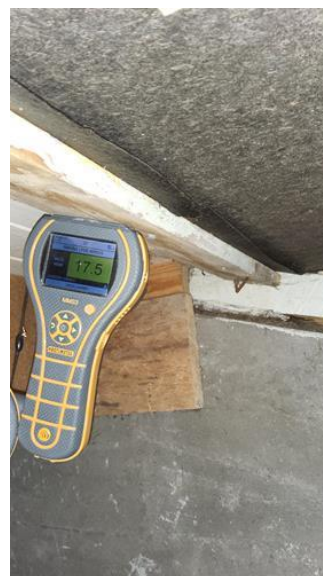
Innvendig inspeksjon - [Fuktmåling i krypkjeller]
