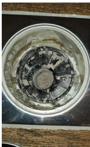
Membran, tettesjikt og overgang til sluk. - [Sluk bad kjeller]
