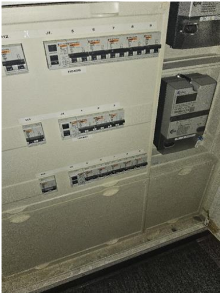
Elektrisk anlegg - [Sikringsskap med automatsikringer plassert i felles gang]
