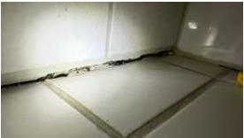
Sprekk i silikonfuge og brudd i tettesjikt.
