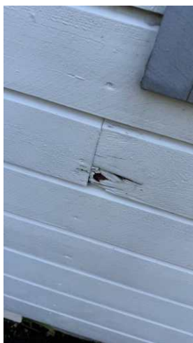
Råteskadet kledning.
