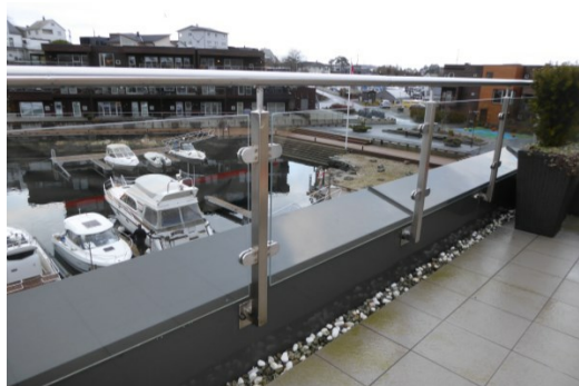
Bildet viser rekkverksløsning, drenserenne og flistekking 3. etg.
