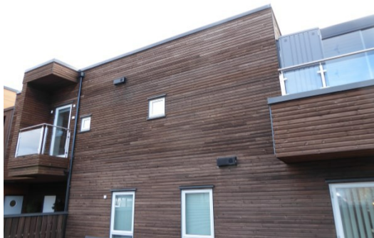
Panelkledning med MøreRoyal 2-trinns behandling.
