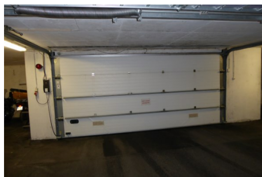
Garasjeport sett fra innsiden.
