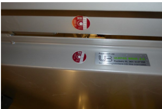
Klassifiseringsskilt på brannør i stål.
