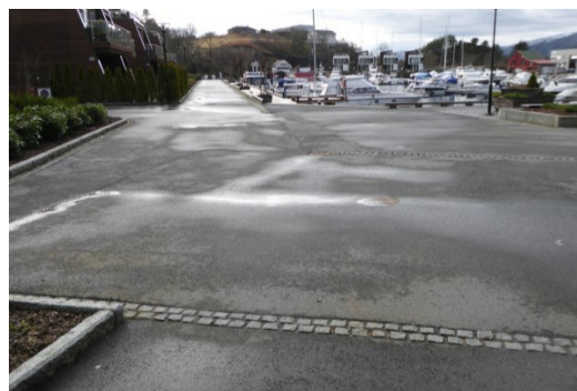
Oversiktsbilde som viser flere overvannssluk og renne.
