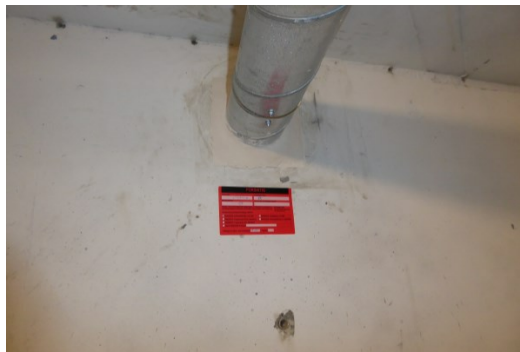
Bruk og dokumentasjon av brannsikker tettemasse ved gjennomføring.
