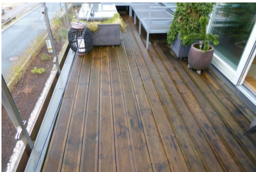
Tretremmegulv på terrasse 2. etasje.
