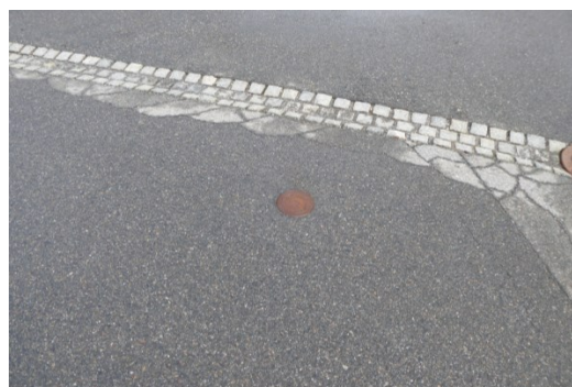
Renne mot overvannssluk.
