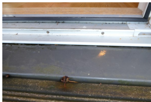
Beslagsløsning ved hev- og skyvedør med vannfilm i overgang.
