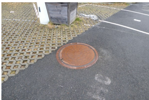
Kum for pumpeanlegg avløpsvann.
