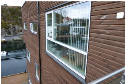
Vinduer med utvendig aluminiumskledning.
