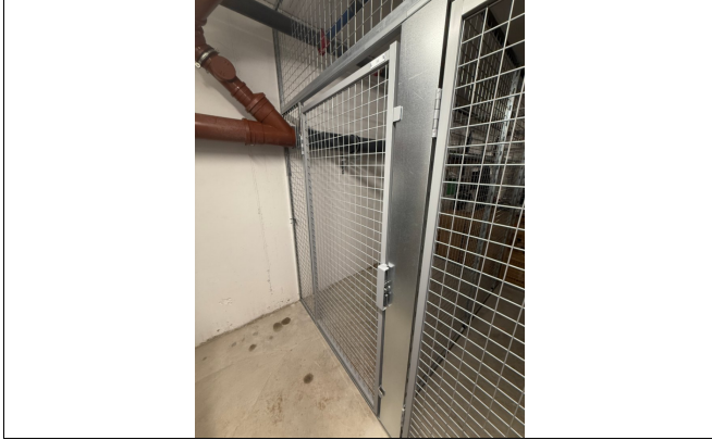
Kjellerbod mrk 34 på 3,2 kvm under oppgang 15 C
