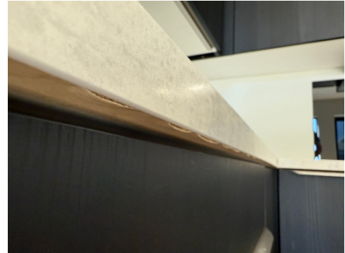
Mindre svelling i benkeplate under kum
