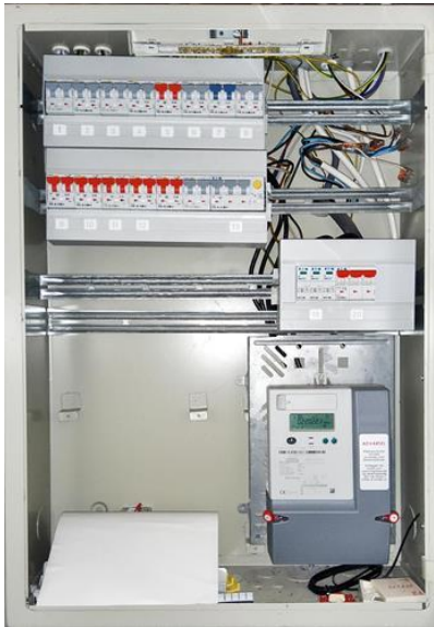
Forenklet vurdering av det elektriske anlegget - [Sikringsskap]
