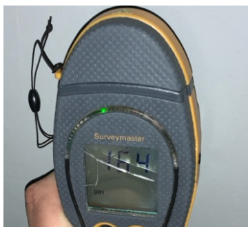
Fuktmåling på vegg i dusjsonen
