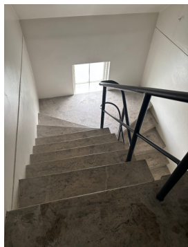
Viser innvendig trapp i felles gang.
