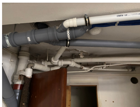
Viser avløp av soil og pvc.
