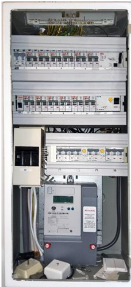
Forenklet vurdering av det elektriske anlegget - [Sikringsskap i entre]
