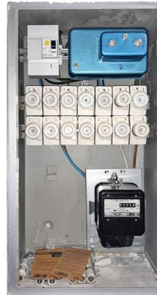
Forenklet vurdering av det elektriske anlegget - [Sikringsskap i soverom]
