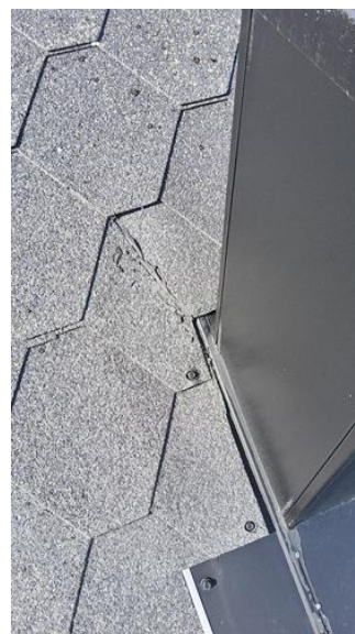
Takgjennomføringer - [Tettedetalj på tak]
