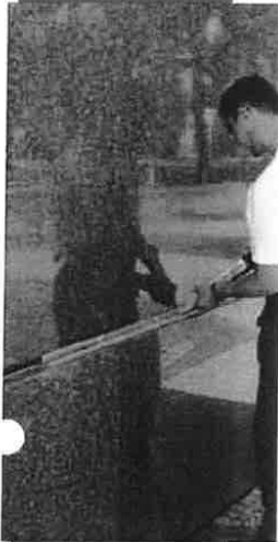
Fuging av fasade med Mapesil LM
