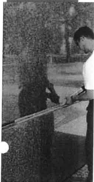
Fuging av fasade med Mapesil LM
