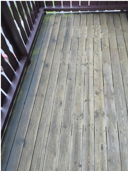
Utkragede eller understøttede konstruksjoner (balkonger, verandaer) - [Balkon ved soverom på loft ]
