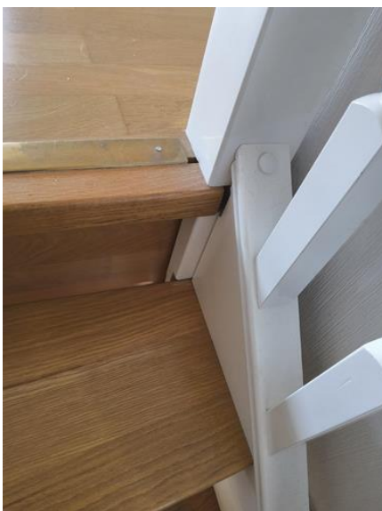
Innvendige trapper - [Innvendig trapp ]
