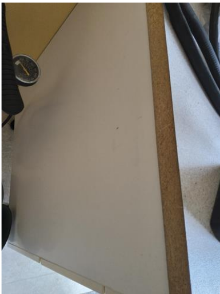
Sanitærutstyr / innredning - [Benkeplate på vaskerom ]
