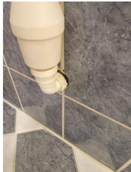
Membran, tettesjikt og overgang til sluk. - [Rørgjennomføring tilknyttet vaskemaskin. Bad i leiligheten]
