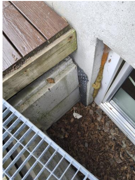
Fuktsikring av grunnmur - [Fuktsikring Grunnmur.]
