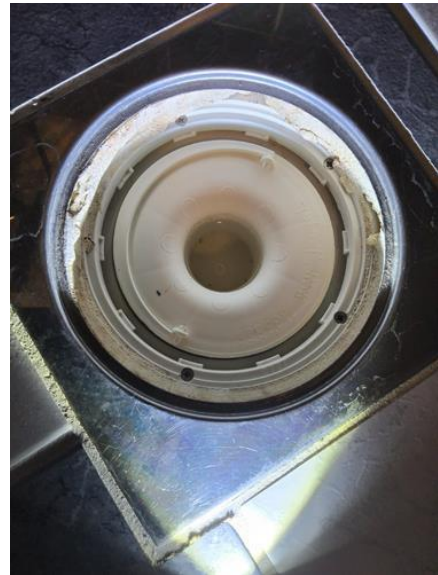
Slukets tilkomstmulighet for rengjøring - [Sluket på bad i leilighet]
