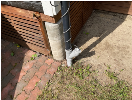
Nedløp ført ned i drenerør.
