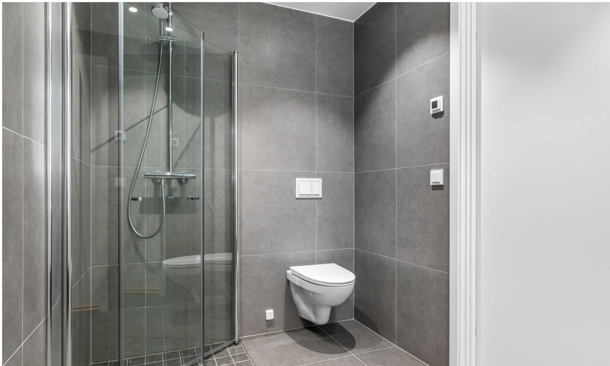
Badet har gulvvarme, vegghengt wc, dusjhjørne og opplegg for vaskemaskin.
