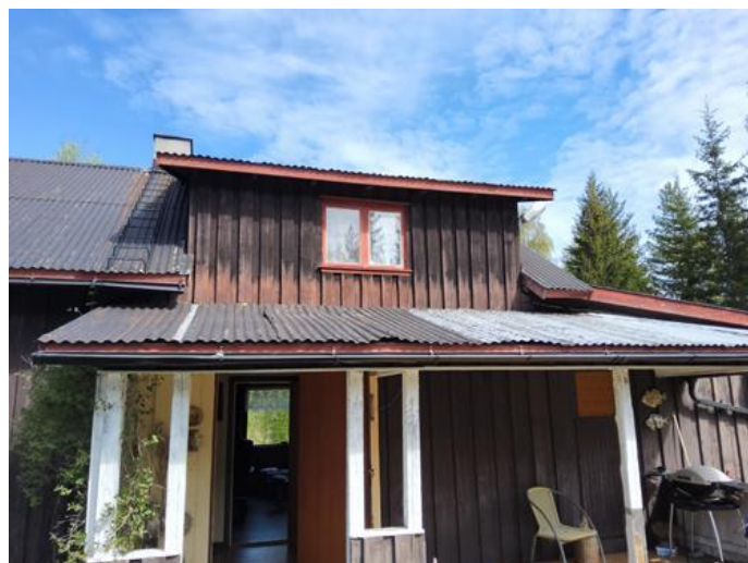
Yttertak - [Tak over inngangsparti og terrasse. ]
