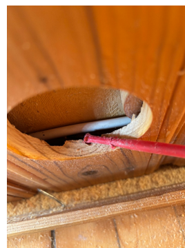
Viser ubeskyttede kabler inne i vegger
