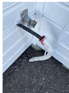
Viser vannledning ut fra veggen og ned i bakken.
