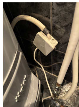
Viser utette rørgjennomføringer.
