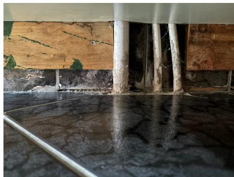
Viser utette rørgjennomføringer.
