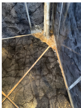
Viser ufagmessig rørgjennomføring.
