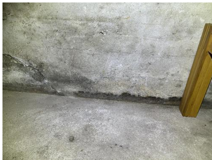
Rom under terreng (kjeller, underetasje, sokkeletasje) - [Fuktmerker kjellerbod]
