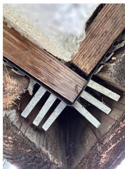
Yttervegger inkl. fasader og konstruksjon - [Manglende musesperre i ytterhjørne]
