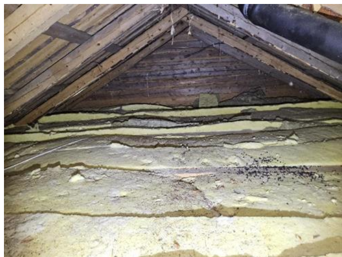
Loft - uinnredet / råloft - [Kaldtloft]
